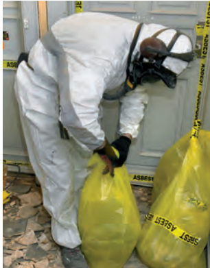
Forsegling af arbejdsområdet og poseforsegling af asbestholdigt materiale beskytter imod spredning af asbestfibre.
